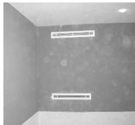
Ansicht aus dem Schwimmhallenraum
