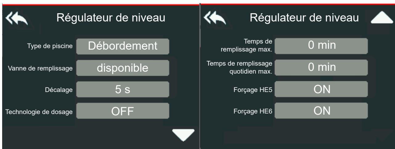
Figure 7 : Régulateur de niveau
