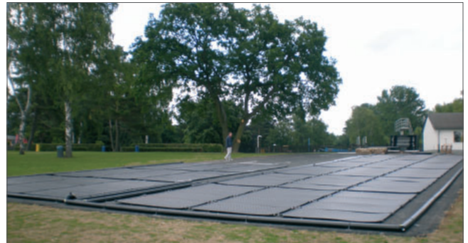
Freiflächenmontage Schwimmbad Wehrheim
