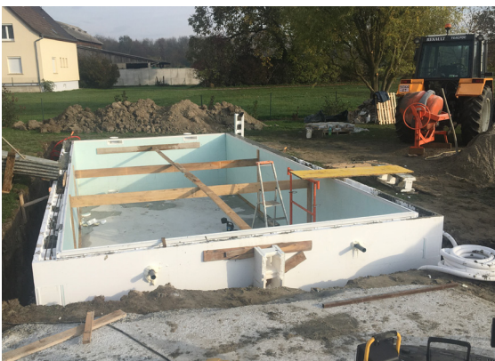
Versteifung der Poolwände vor der Befüllung
