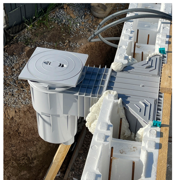
Einschäumen der Einbauteile sorgt für einen festen Sitz
