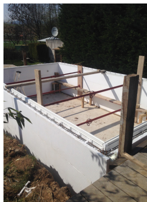
Versteifung der Poolwände vor der Befüllung
