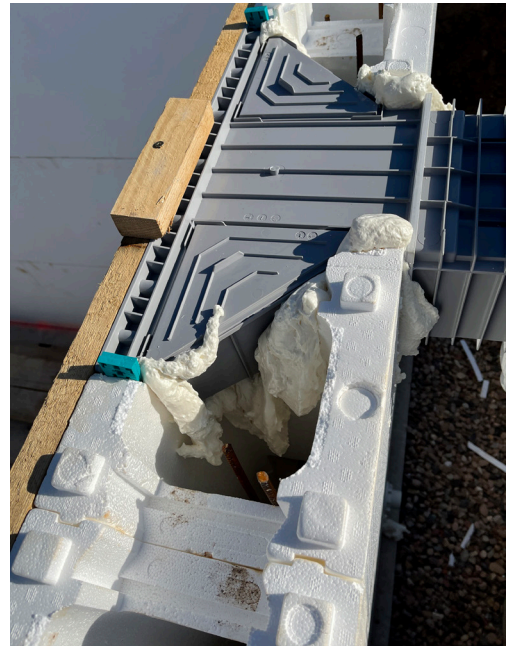
Einschäumen der Einbauteile sorgt für einen festen Sitz
